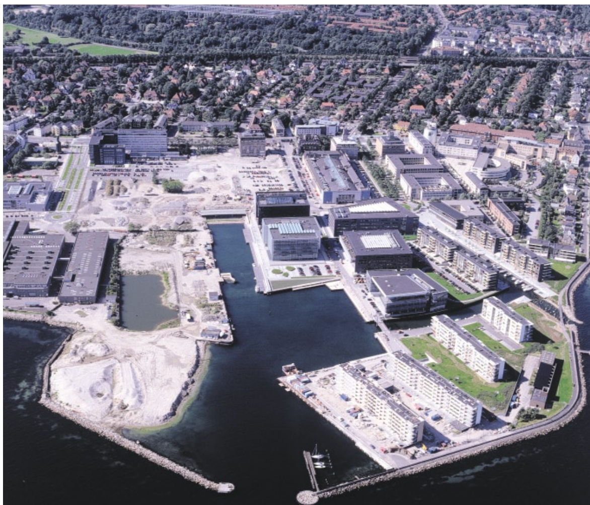
På luftfotoet ses det stort set udbyggede Tuborg Nord til højre og de store byggetomter i Tuborg Syd til venstre. Tuborg Boulevard ses øverst, lidt til højre for midten.
