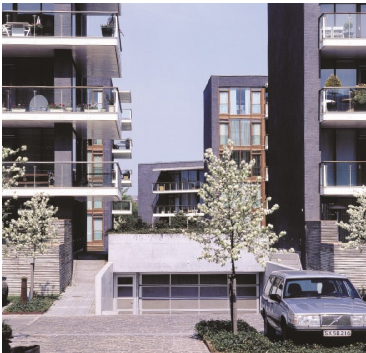
Vilhelm Lauritsens boligblokke i Tuborg Havn er opført på hver sin side af en nygravet kanal.
